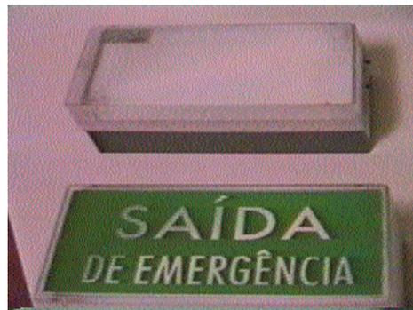
A iluminação de balizamento é aquela associada à sinalização de indicação de rotas de fuga, com a função de orientar a direção e o sentido que as pessoas devem seguir em caso de emergência.
