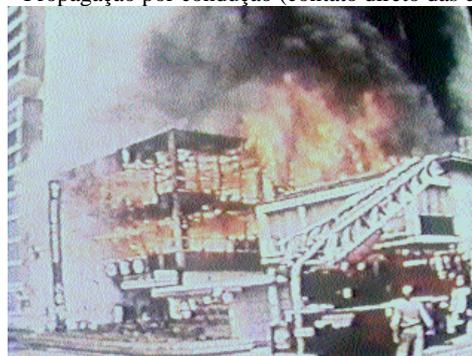
Figura 8 - Propagação por convecção, onde gases quentes fazem com que ocorra focos de incêndio em andares distintos
